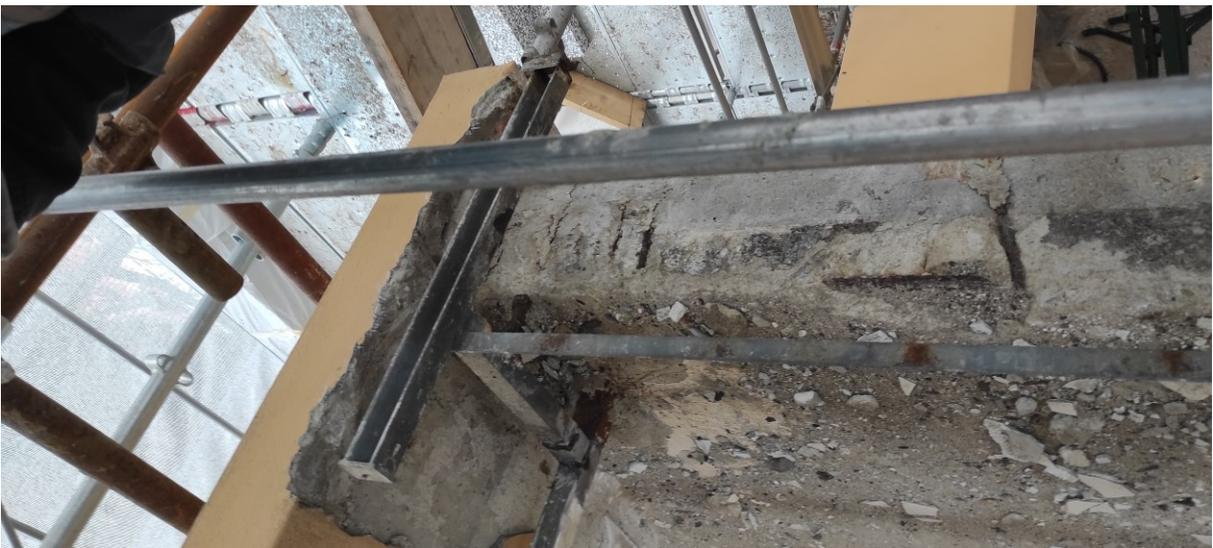
È stato eseguito il taglio dei traversi della struttura e raccordo con allungamento di 5 cm.
