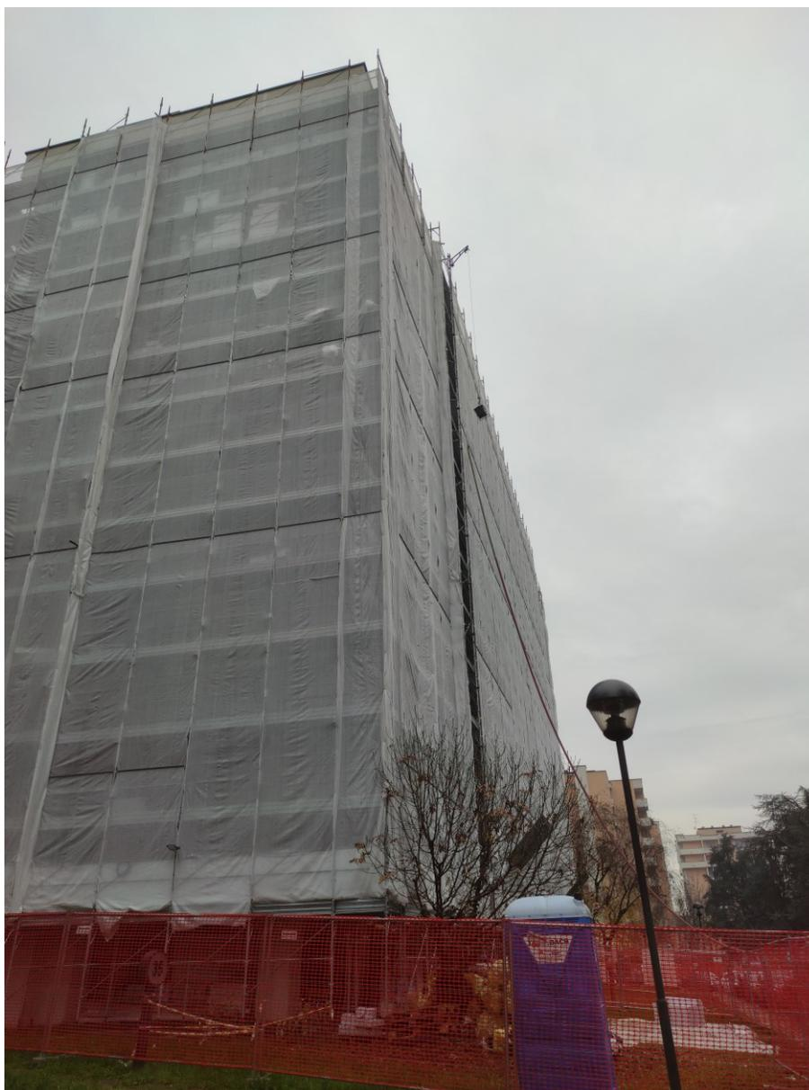
Al civico 33 gli operai stanno montando gli avvicinamenti del ponteggio per effettuare le lavorazioni sui balconi.
